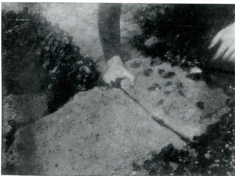
Fig. 4. Detaliu de îmbinare a dalelor din calcar cu care este pavat digul.
